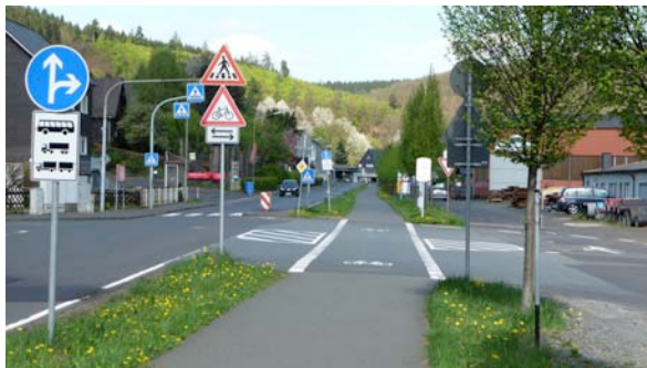
Gefährlicher Kreuzungsbereich: K 93, Eisenstr., Industriestr., Radweg
