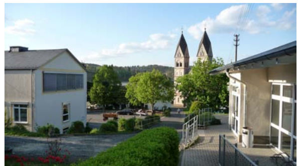
Geplanter Nahwärmeverbund; schadhafte Straße zur Turnhalle
