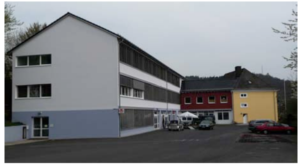
Ehemalige Grundschule Fischbacherhütte mit Räumen für gewerbliche Nutzung, Polizei und Gemeindebüro
